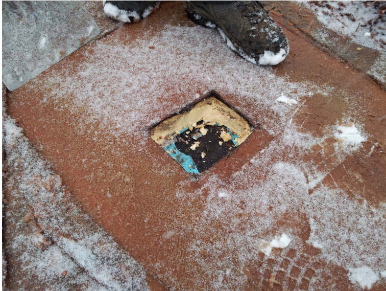
Dachaufbau mit PU
