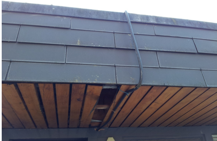
Dachaufbau, kleinformatige AZ-Platten
