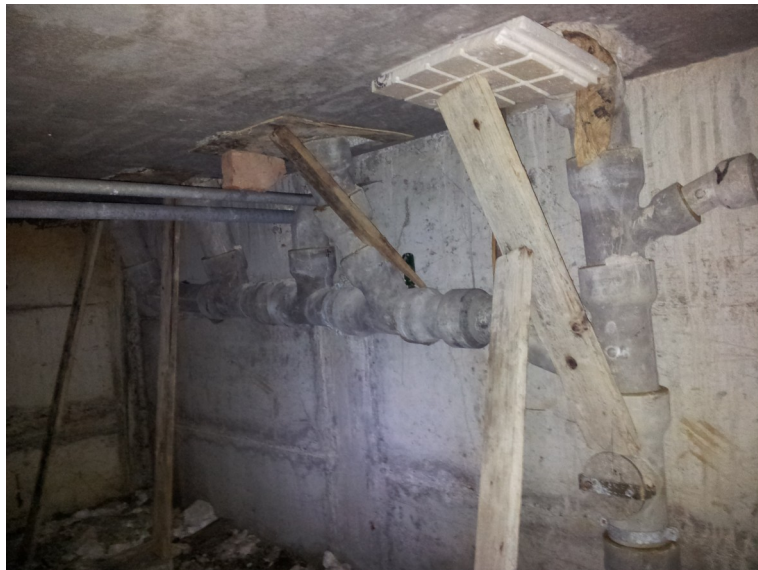
Abflussrohre aus Asbestzement im Kriechkeller
