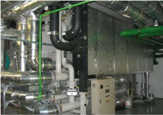
Abb. 5.6: Adsorptionskältemaschine der Firma Festo
