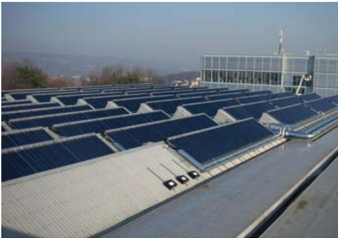
Abb. 5.7: 1330 m<sup>2</sup> Röhrenkollektoranlage der Firma Festo
