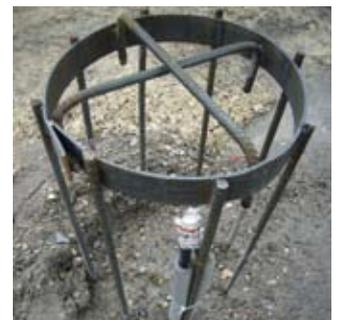
Abb. 5.9: Thermisch aktivierte Bohrpfähle
