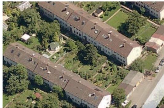
In der Untersuchung des Ingenieurbüros ebök (2013) anlässlich des Energietags am 20. Juni 2013 wurde für ein „Musterhaus R“ ein Sanierungsziel mit Energiestandard Effizienzhaus (EffH) festgelegt und in vier Varianten EffH 70 bis 115 gerechnet. Beim IST-Zustand wurde von ungedämmter Außenwand, Zweifach-Wärmeschutzverglasung, minimal gedämmtem Dach, ungedämmter Kellerdecke und einer Wärmeversorgung mit Gas ausgegangen.
