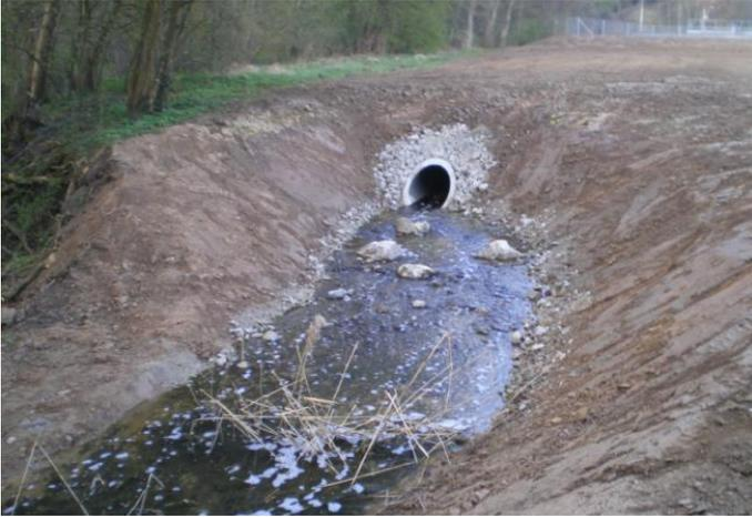
Entlang dem Kläranlagengelände wurde auf Flst. Nr. 4119 ein bis zu ca. 1 m hoher und an der Dammkrone 1,0 m breiter Deich (Böschungsneigung 1:3) vom Ufer der Körsch bis zum Anschluss an die Böschung des bestehenden Geh- und Radweges hergestellt.
