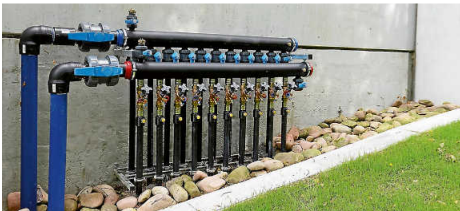
Erdwärmesonden-Verteiler.
