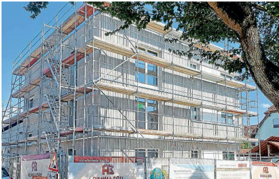
Der Bau des Wohnhauses geht zügig voran.
